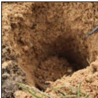
First, dig a hole
